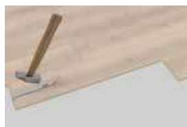
5. Hit the short of the plank until it fits together. Golpear el lado corto hasta encajar. Il faut frapper le petit côté jusqu'à ce qu'il s'enclenche en place.
